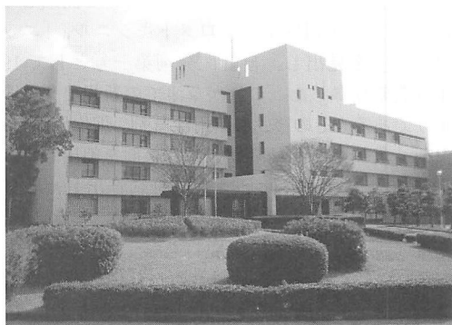
新研究棟(1984年竣工, 1号棟)全景
