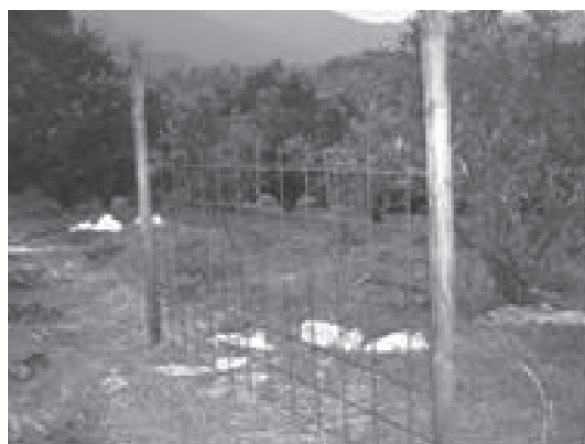
図-4 杭とワイヤーメッシュの設置状況
