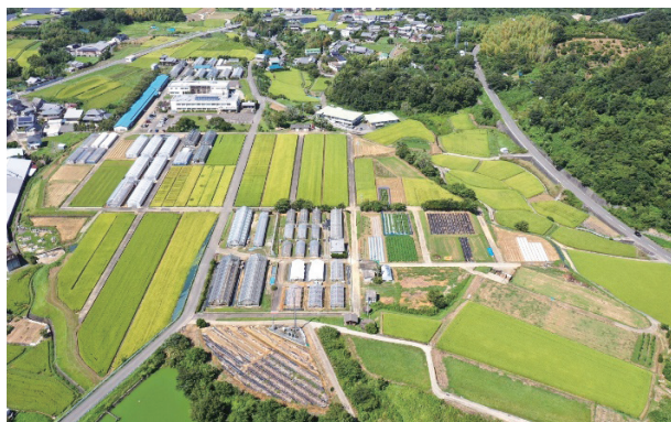
図-1 試験場の全景
