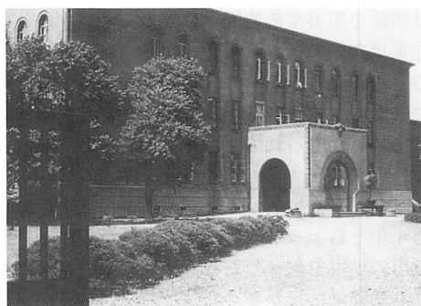
図-1 西ヶ原の研究本館
