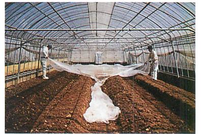
⑥マルチを張り作業終了
