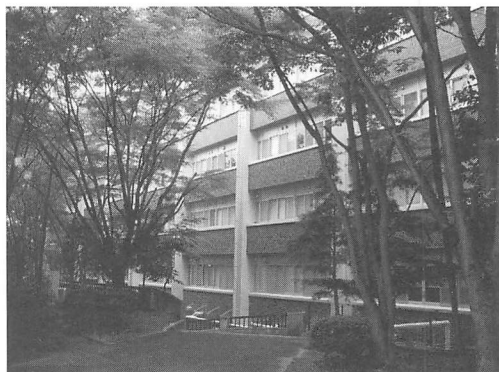
改修工事が終わった農学部総合館南棟
