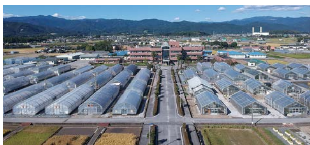
図-1 高知県農業技術センター全景
