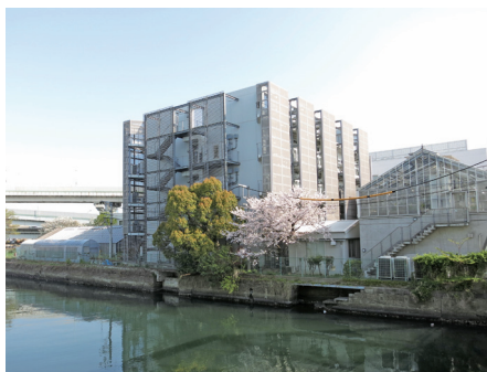
新山下庁舎の外観写真
