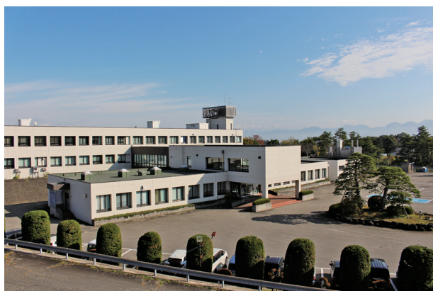
研究棟・管理棟の外観
